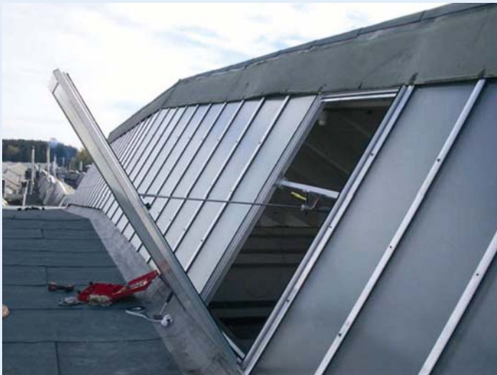
Einbau in bestehende Shedverglasung
