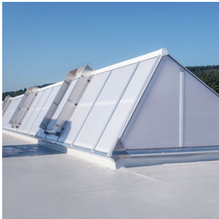
Lucernario Continuous Rooflight S de LAMILUX en la nave industrial de Kemper GmbH en Olpe
